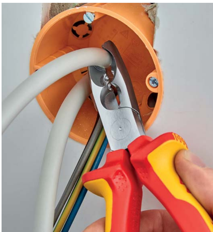
Ściąganie izolacji z przewodów w puszkach instalacyjnych
