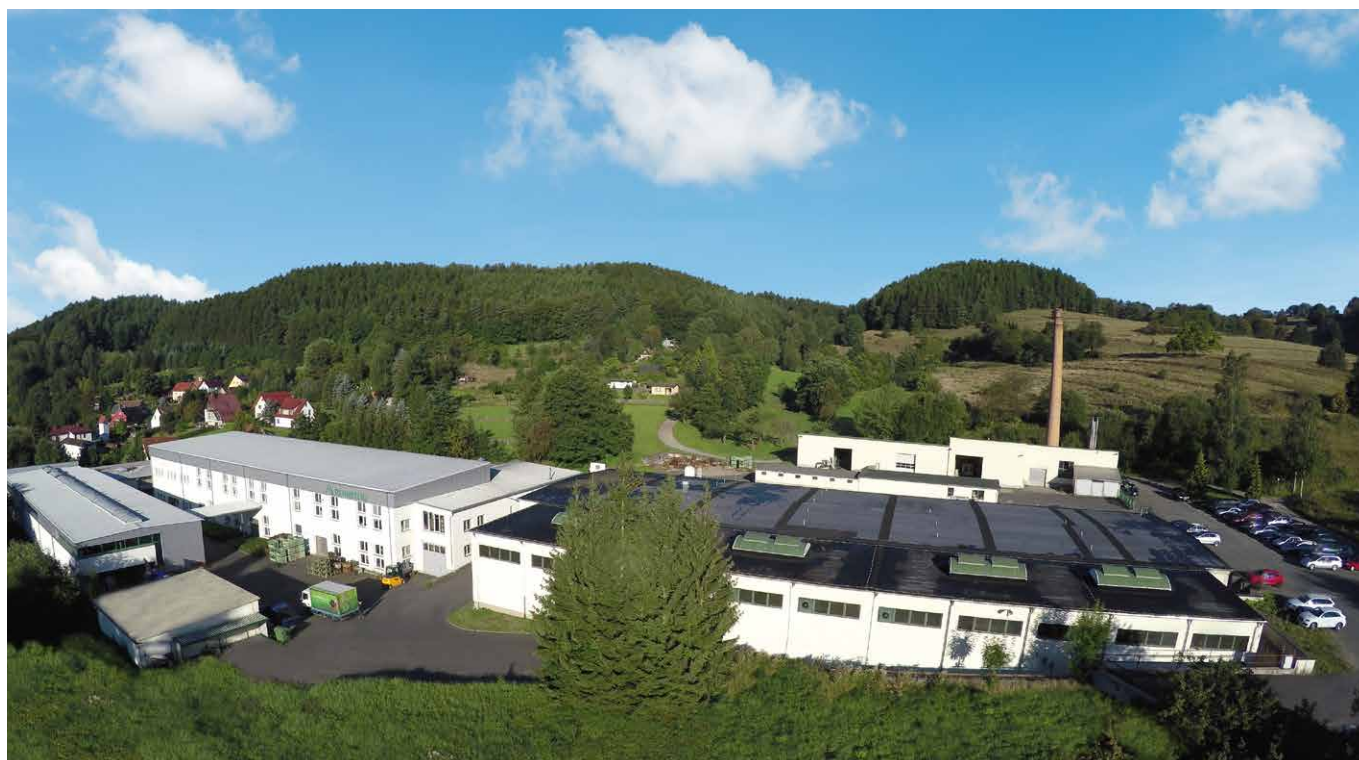
Betriebsteil Altersbach Manufacturing site Altersbach
