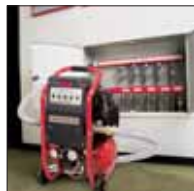
Czyszczenie instalacji ogrzewania podłogowego
